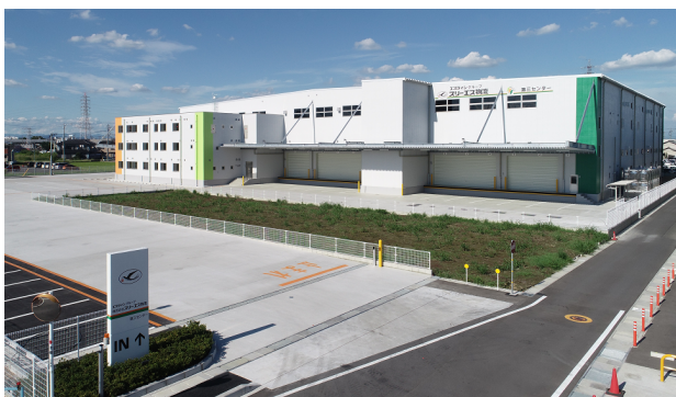
スリーエス物流第三物流センター
