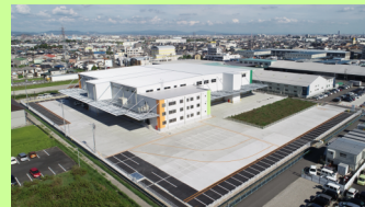
スリーエス物流第三物流センター
