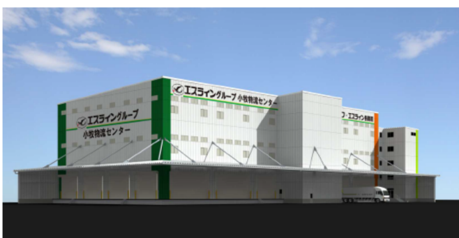
エスライングループ小牧物流センター
