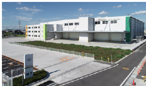
スリーエス物流第3物流センター
