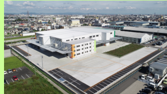
スリーエス物流第3物流センター
