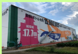
エスラインギフ飲料保管用自動倉庫
