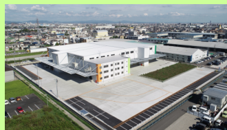
スリーエス物流第3物流センター
