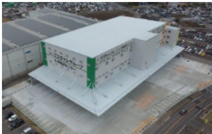
エスライングループ小牧物流センター
