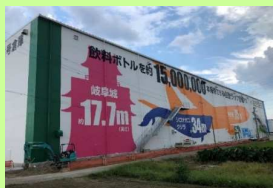
エスラインギフ飲料保管用自動倉庫
