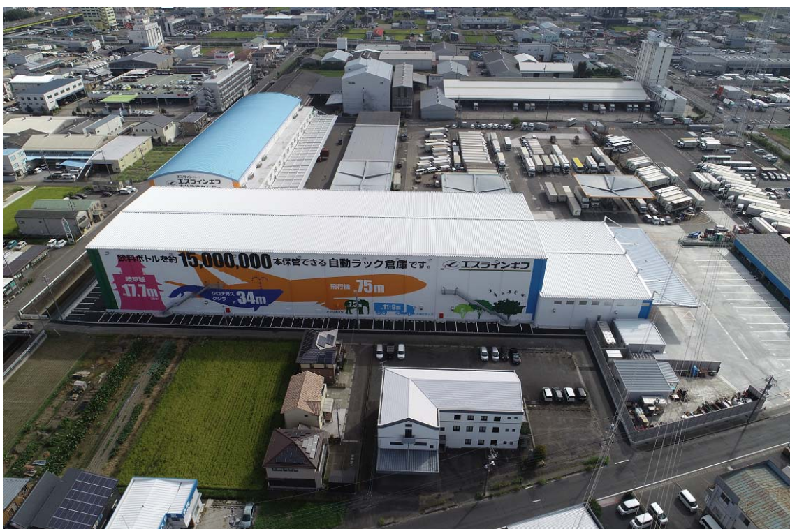
<完成した飲料保管自動倉庫ならびに壁面描写>
