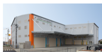
エスラインギフ豊田第1物流センター エスラインギフ豊田支店隣接 2階建倉庫延床面積：4,187.11㎡ 建築費：4.8億円
