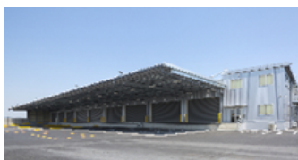
エスラインギフ豊田支店 住所：愛知県豊田市 敷地面積：6,285.71㎡ 建築費：4.5億円
