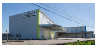
エスラインギフ豊田第2物流センター 住所: 愛知県豊田市福受町 延床面積: 5,479.79㎡
