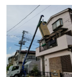
ユニック車による 吊上げ作業
