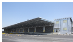
(株)エスラインギフ豊田支店 (豊田市)
