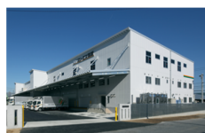
(株)スリーエス物流本社第1センター (一宮市)
