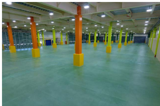
〈1階荷捌きホーム〉(エスラインギフ)
